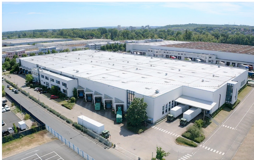
ID Logistics hat in Ginsheim-Gustavsburg sein erstes Sortier- und Verteilzentrum in Betrieb genommen. Bildrechte: CBRE
